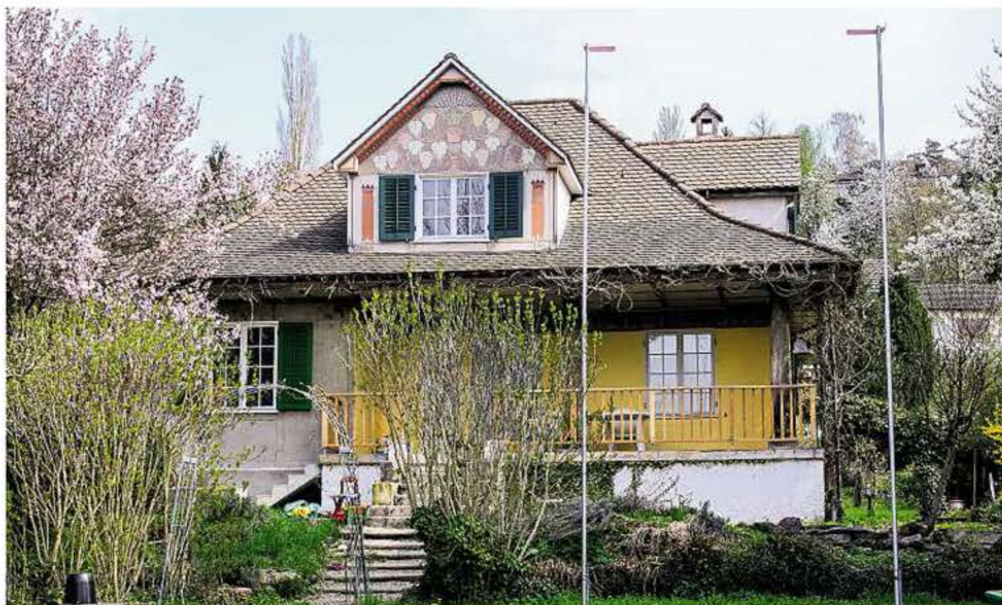
Der Abbruch des farbenfrohen Aryana-Hauses an der Langackerstrasse 126 aus dem Jahr 1915 – genannt «Efeuhüsi» – erfolgte 2012.
