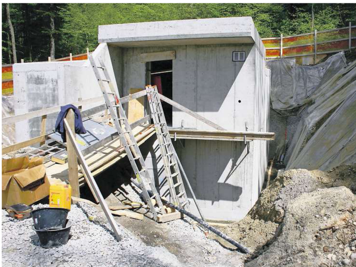
Das neue Reservoir Holzboden im Bau. Bild: zvg
